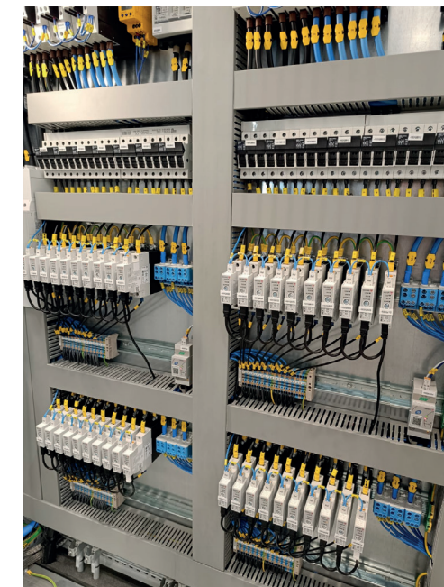
Rozvaděč se systémem NRG pro precizní spínání a monitorování topné zátěže v sekcích po deseti spínacích bodech.
