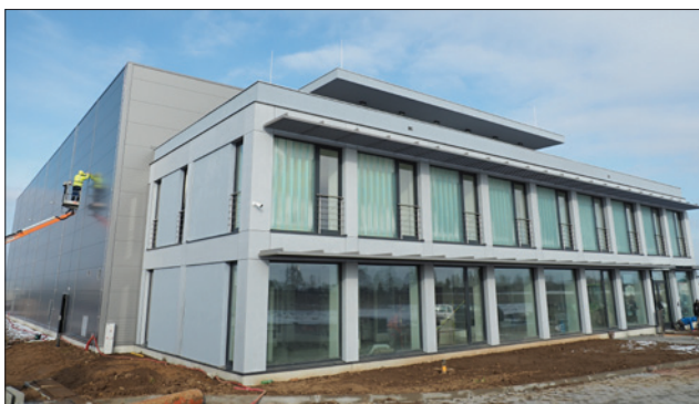
Obr. 1. Administrativní a logistické centrum Merida
